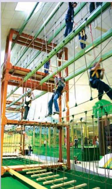
Der SkyTrail (engl. Himmelspfad) ist ein Hochseilgarten auf Basis einer selbst tragenden Stahlkonstruktion, bestehend aus drei „Türmen“ mit Plattformen. Auf 3 Ebenen sind zwischen den Plattformen unterschiedliche Kletterelemente (bestehend aus Seil, Stahl und Holz) eingebaut. Für die erste Ebene mit Übungen in nur 30 cm Höhe sind keine Sicherungssysteme notwendig. Die zweite und dritte Ebene befindet sich in 3 m bzw. 6,50 m Höhe. Insgesamt sind 22 verschiedene Übungen möglich.
